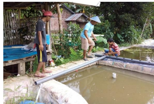
Gambar 1. Pemasangan instalasi aquaponik
